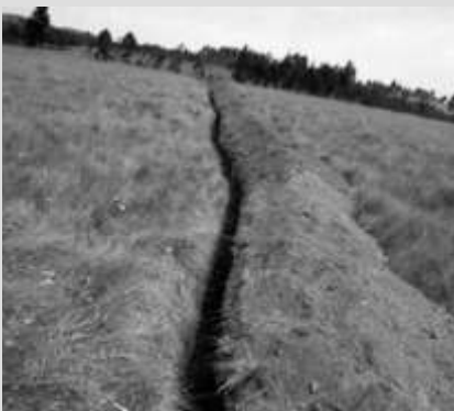
Der Graben, in dem das Wasserrohr verlegt werden wird.
