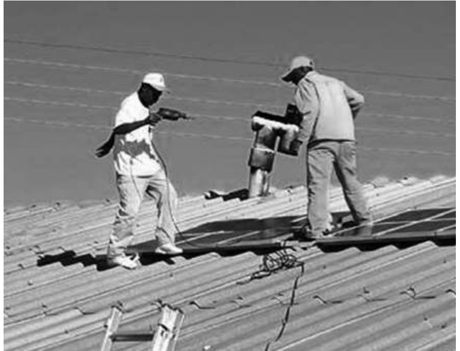
Das Solardach auf der Schule wird montiert.
