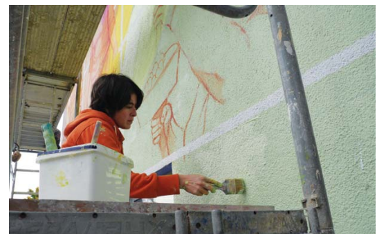
Katy grundiert die Fläche der Hauswand.
