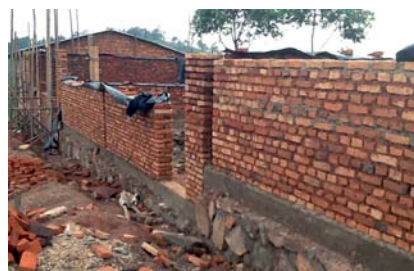
Es geht voran: So weit war der Schulneubau im Januar 2016.
